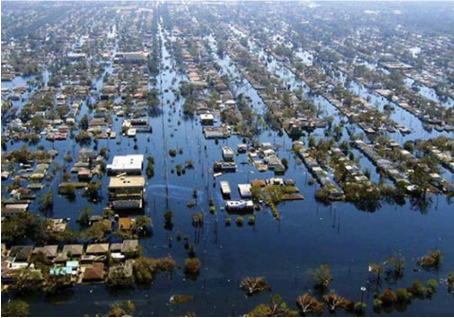
Vista de un sector de La Plata totalmente anegado tras la trágica inundación del 2/3 de abril del 2013.
